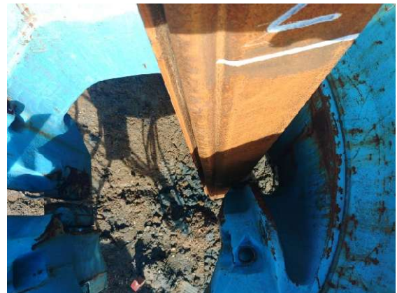
NS コネクター建込時のジャック内の様子
