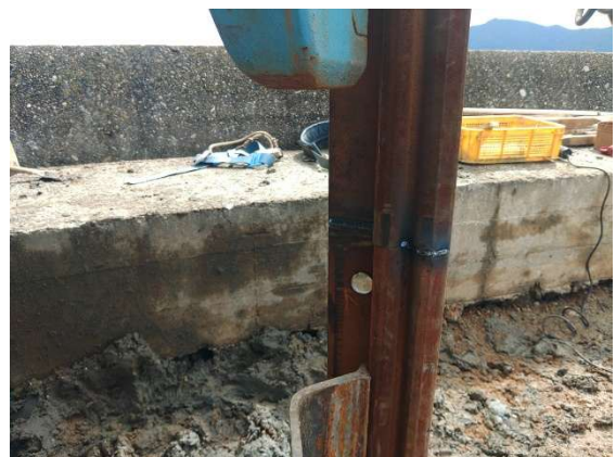
継溶接完了
