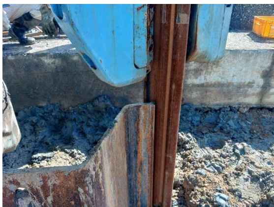
ジャックが隣接する鋼矢板天端に 接触するので注意が必要
