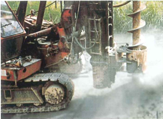
工事場所／伊勢自動車道五十鈴川高架橋工事 使用機械／DHJ-30ジュニア
